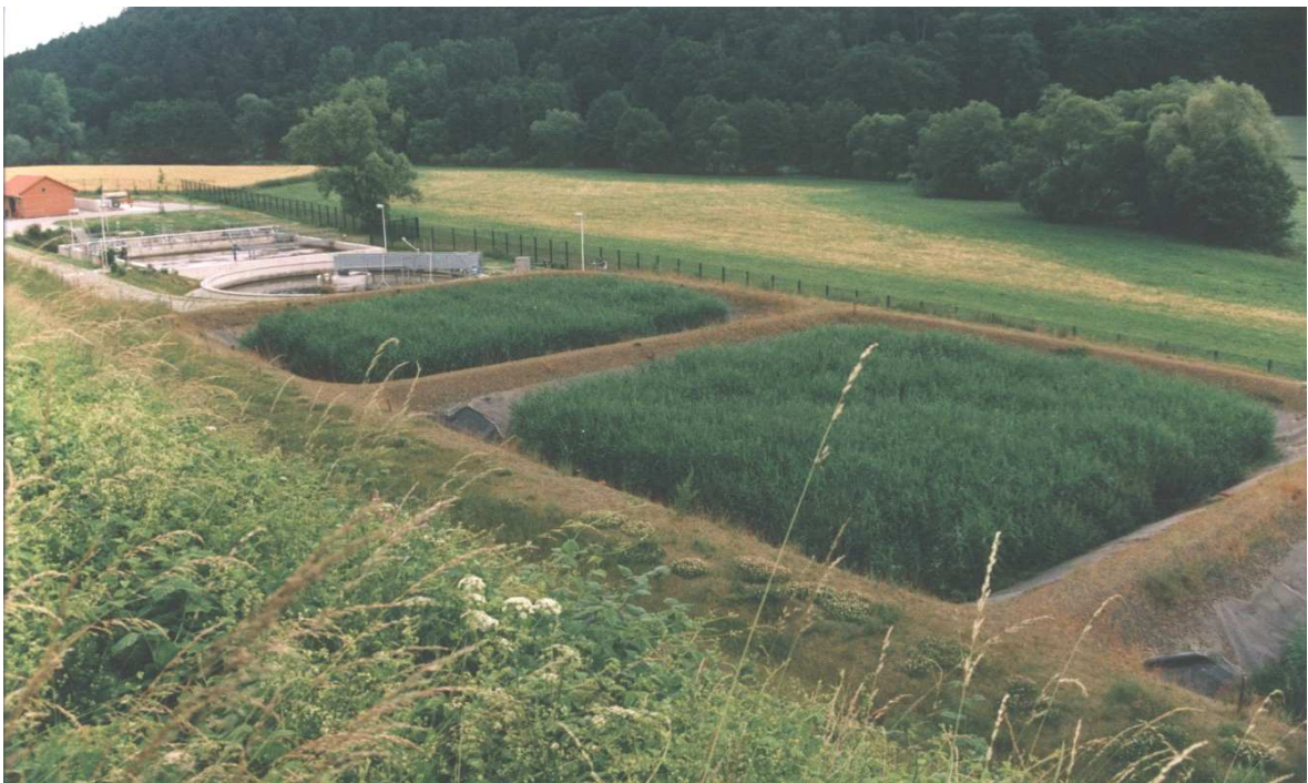
Naumburg 芦苇床污泥处理系统，床 1 和床 2 (总体面积 2.400 m 2 ) 最高可达 4 m; 根茎密度达 320 Stück/m 2 , 后面为氧化池
